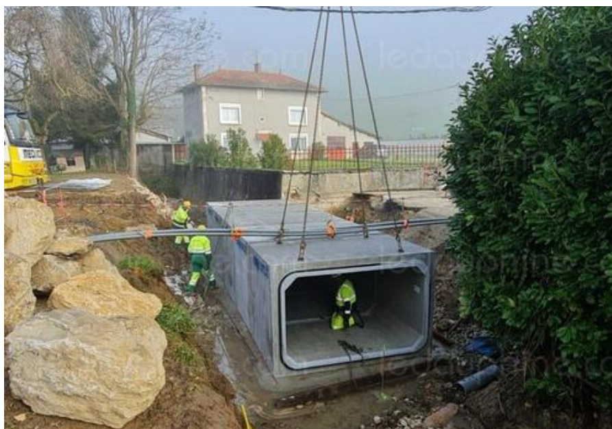
Installation des cinq ouvrages pour le pont du Joux. Photo Le DL/Françoise Granjon
